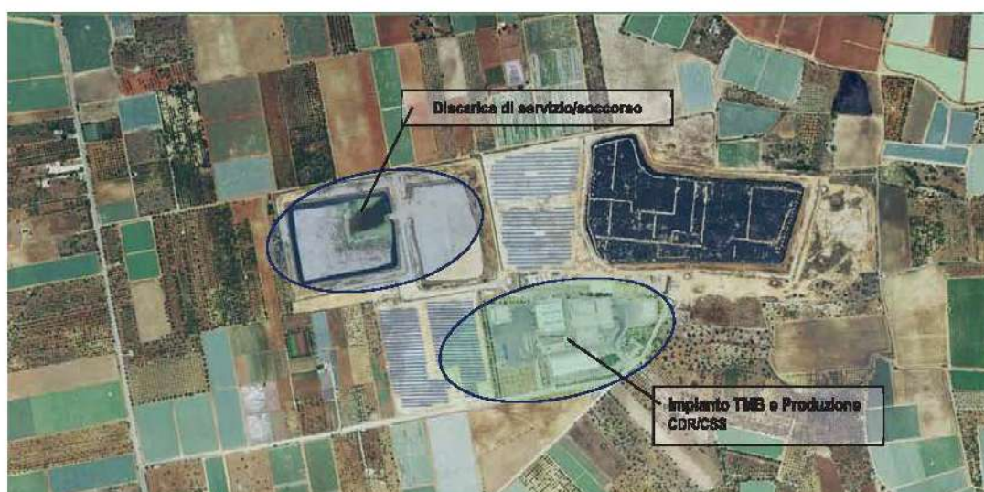
Figura 1 – Ubicazione complesso impiantistico (Ortofoto 2013)
